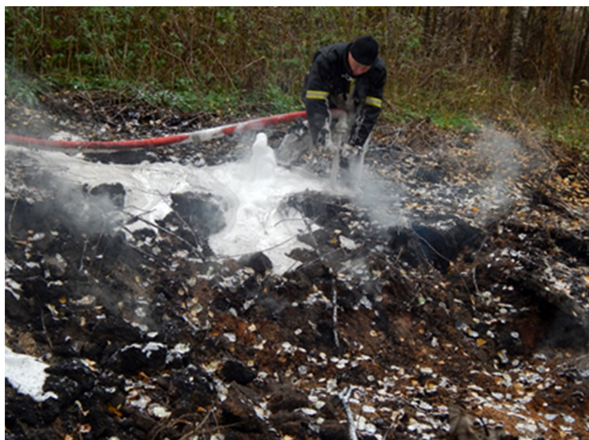
Рис. 5. Тушение торфяного пожара компрессионной пеной с использованием модернизированного торфяного ствола
